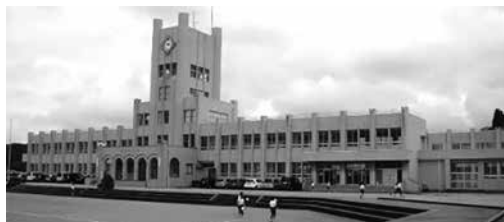
【グラウンド側から見た校舎】
